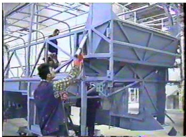
انجام عملیات سیلر کاری اسکلت فلزی
