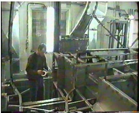
عملیات نوار چسب کاری
